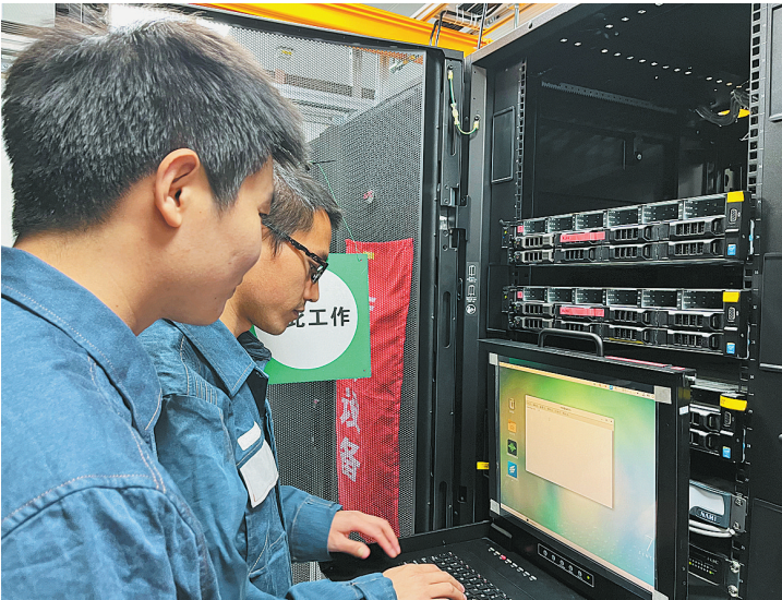
专业技术人员进行系统漏洞排查。
